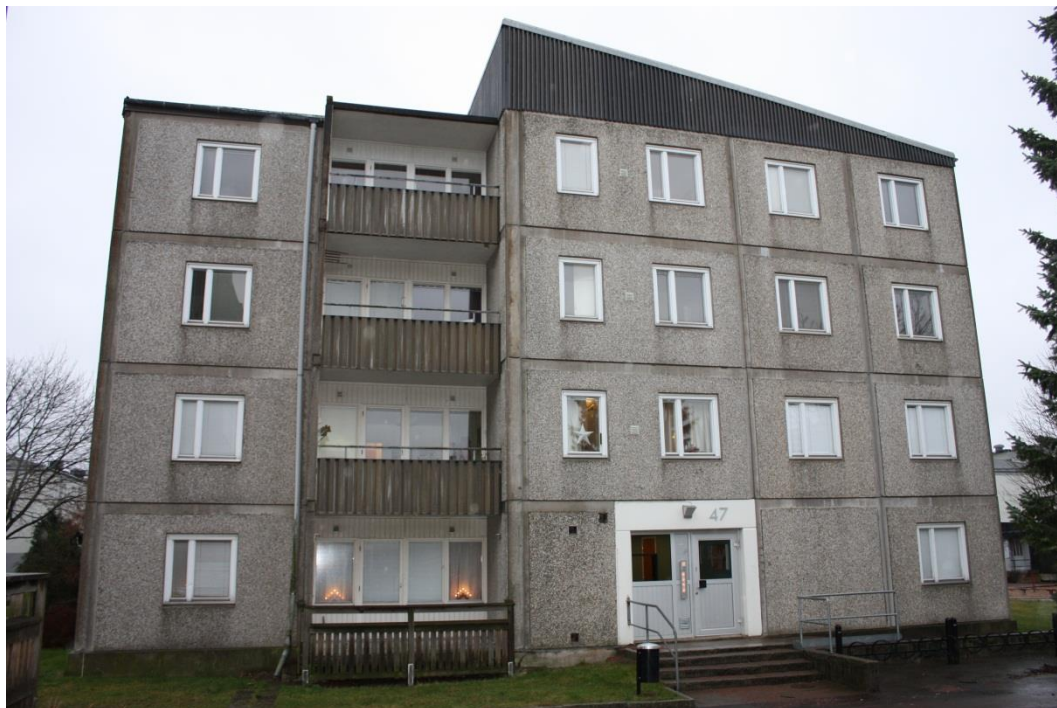
Figur 8 Katjas gata innan renovering
